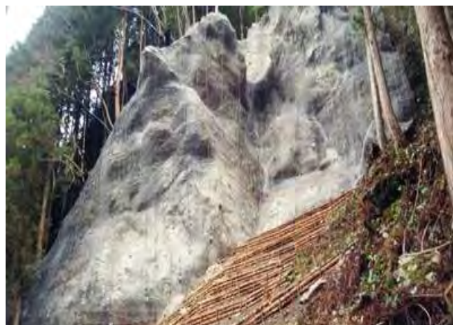
仁淀川町岩屋地区 (ロープ伏工・岩塊固定工)
