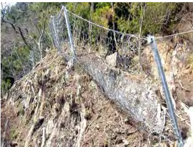
安芸市下山地区 (リングネット工)
