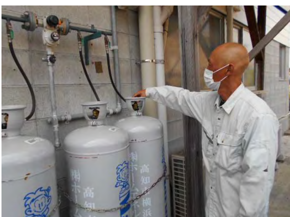
※新しいガスタンクは地震時には自動的に閉じる構造であるが、念のため手で閉まっているか確認する
