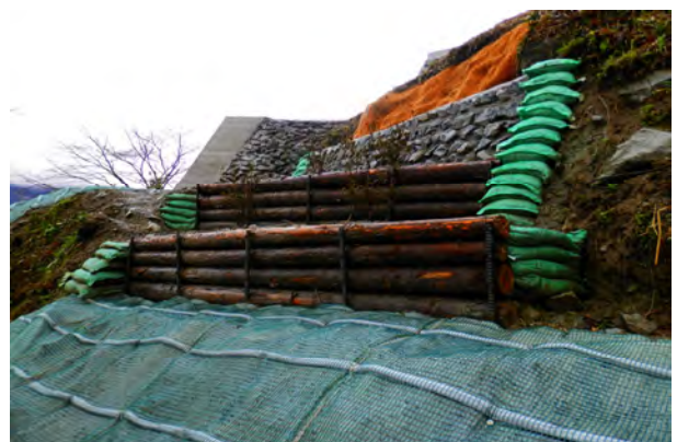
木柵設置と植生シート
