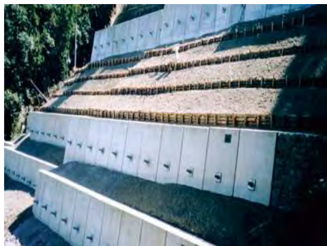
室戸市吉良川町釣の口地区 (アンカー工)
