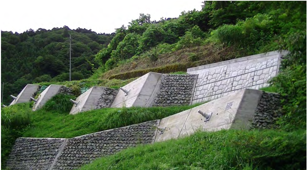
※法面は植生で覆われて自然環境に溶け込んでいます。
