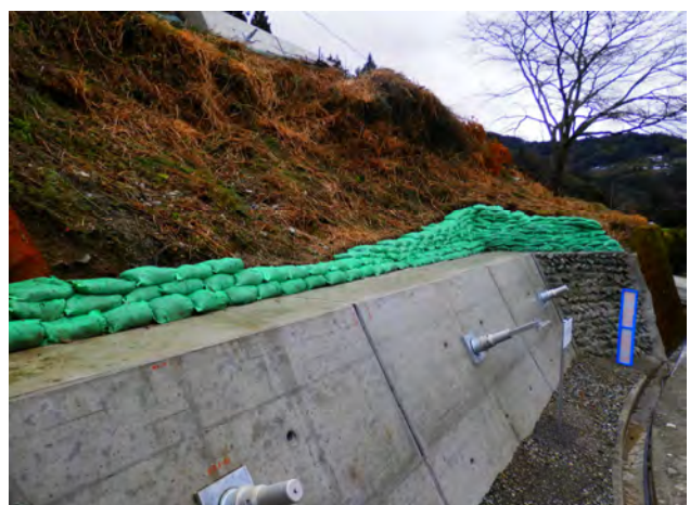
植生土のう設置（法面保護）
