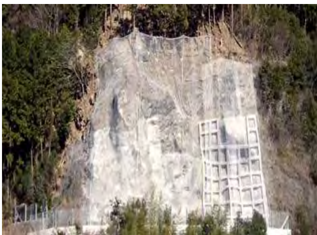
久万高原町中津地区 (ネットワン工・岩塊固定工)
