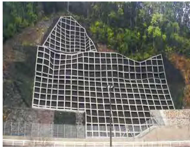
中土佐町奥大坂地区 (現場吹付法枠工法)
