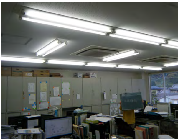
【着工前・・・蛍光灯】
