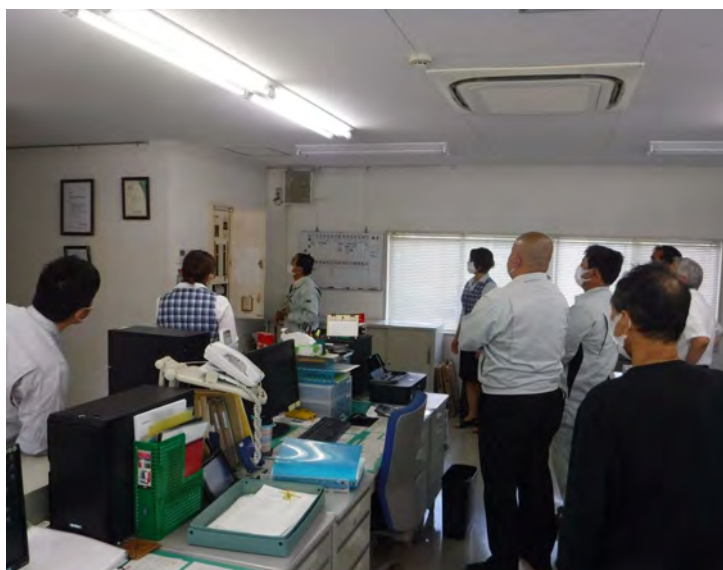
【電気：分電盤の確認】
